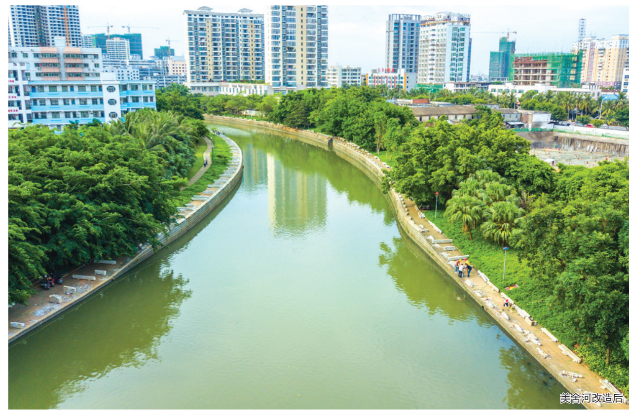
改造后的滨海大道
